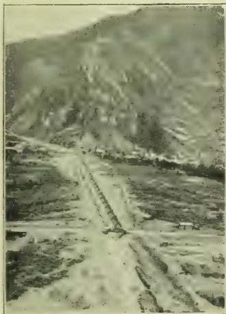
FIG. 166. — CHENAL SUR LE CÔNE DE DÉJECTION DU TORRENT DE SAINT-JULIEN (SAVOIE).
